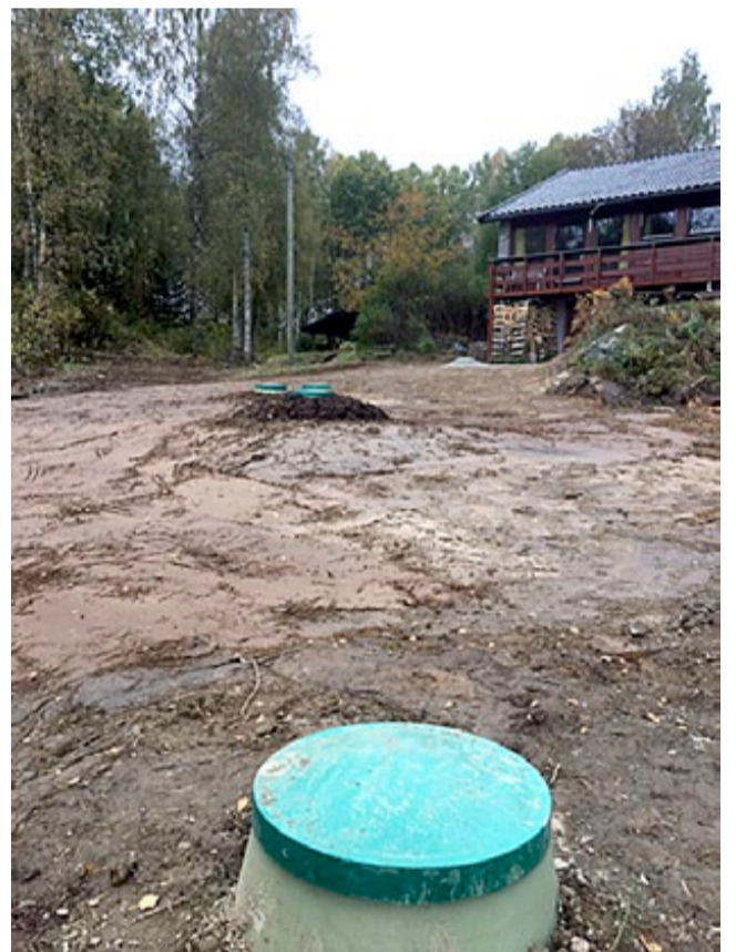
Det nye renseanlegget muliggjorde at terrenget foran hytta samtidig ble planert.
