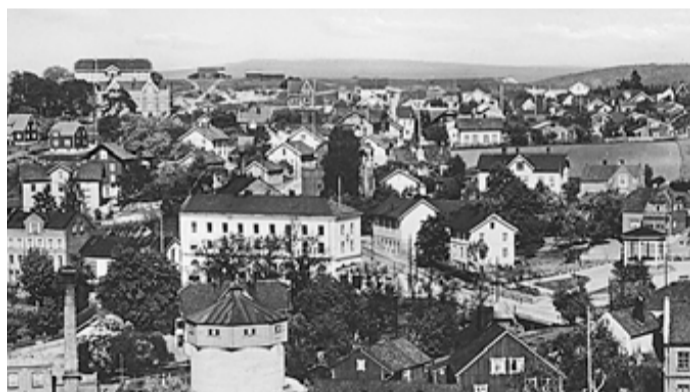
Forbrugsforeningen Tista bygget den store forretningsgården i 1923-24 og tok den i bruk i januar 1925. Gården rommet både bakeri, pølsemakeri, manufaktur, glass og stentøy, meieri og kolonial.
