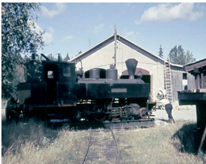
Manuell dreining av lokomotiv på svingskiva. Tre personer trengtes for å få snudd Tertitten.
