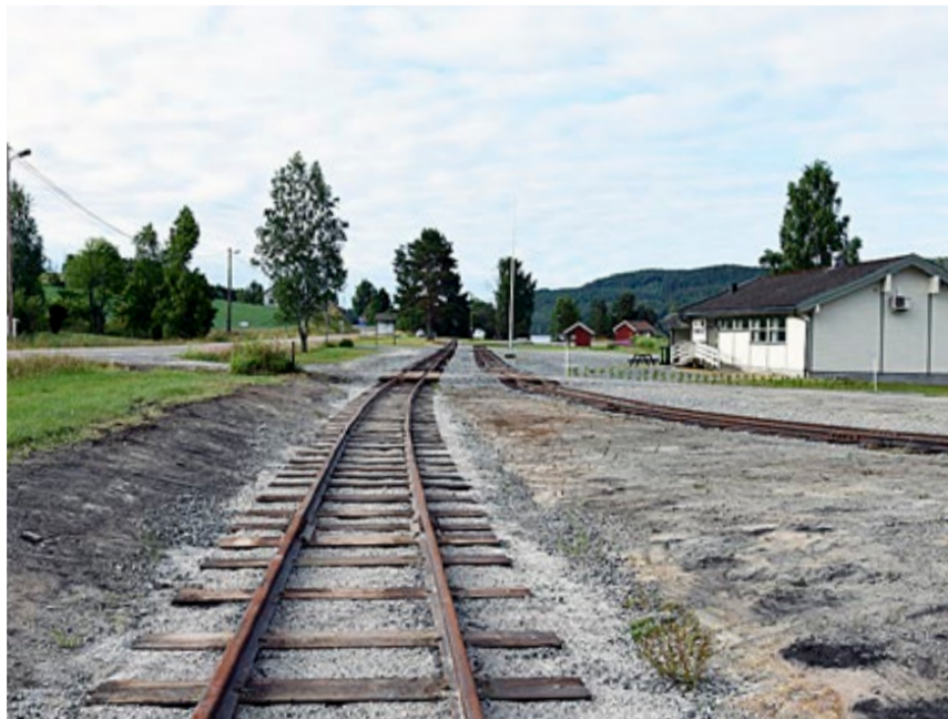
Grendehuset på Skulerud blir flittig brukt. Mellom veien og huset er det lagt nye jernbanespor, slik de lå i 1960. Foto: Steinar Fundingsrud
