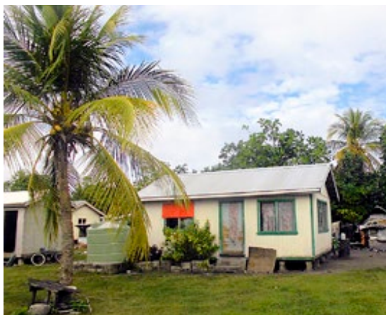
Husene på Niuatoputu måtte gjennombygges etter at hele øya ble rasert av en tsunami noen få år tilbake.
