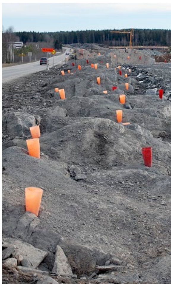
Mye sprengning må til for å bygge vei. Slik så det ut på Sletta i 2015.
