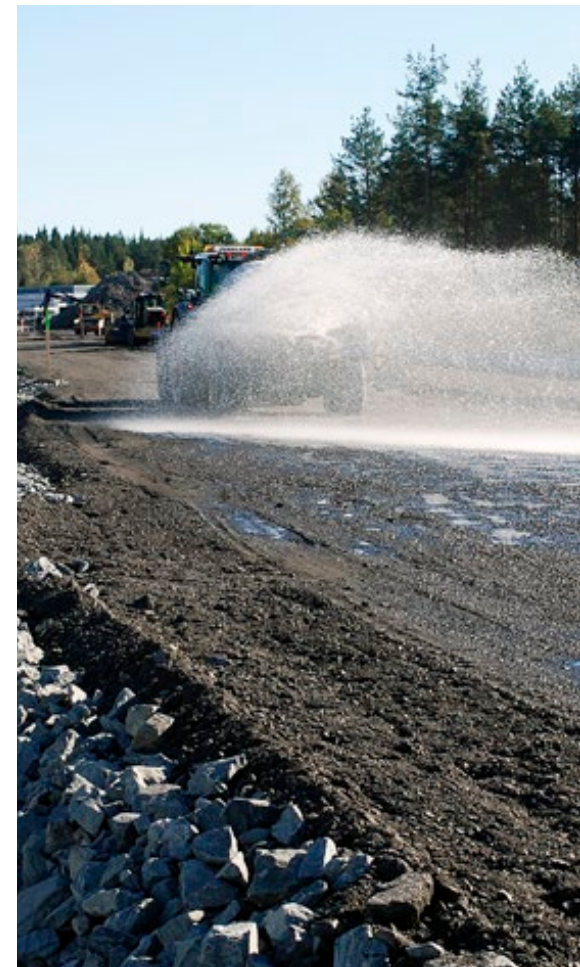
Strekningen østover fra Kilebu vannes før asfaltering.
