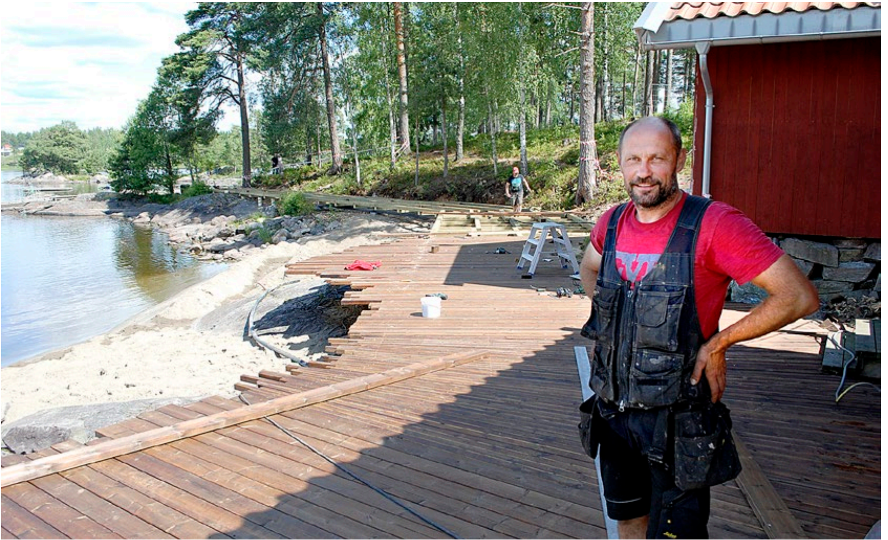
I sommer har Ørje fått nok en attraksjon; en flott bryggepromenade. Byggmester Tommy Rambøl legger her siste hånd på verket.
