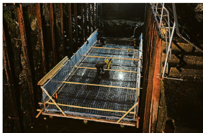
Båtcafeen skal ligge på et nytt flytefundament som Tommy Rambo i vinter har bygget i øverste slusekammer. (Foto: Jørn A. Fjeld)
