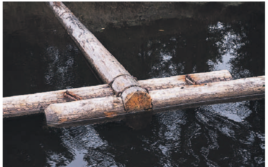
Dette er krampelenser, som Iver og Helge har jobbet med å få på plass i vassdraget.
