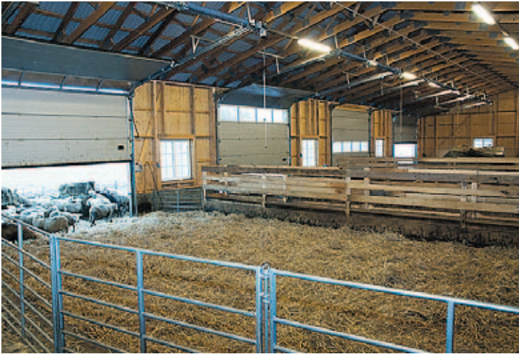
Det er høyt under taket og god luft i det nye fjøset. Rør er isolert for at vannet ikke skal fryse.
