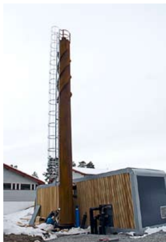
Fjernvarmeanlegget skal produsere varme til blant annet skolen og barnehagen.
