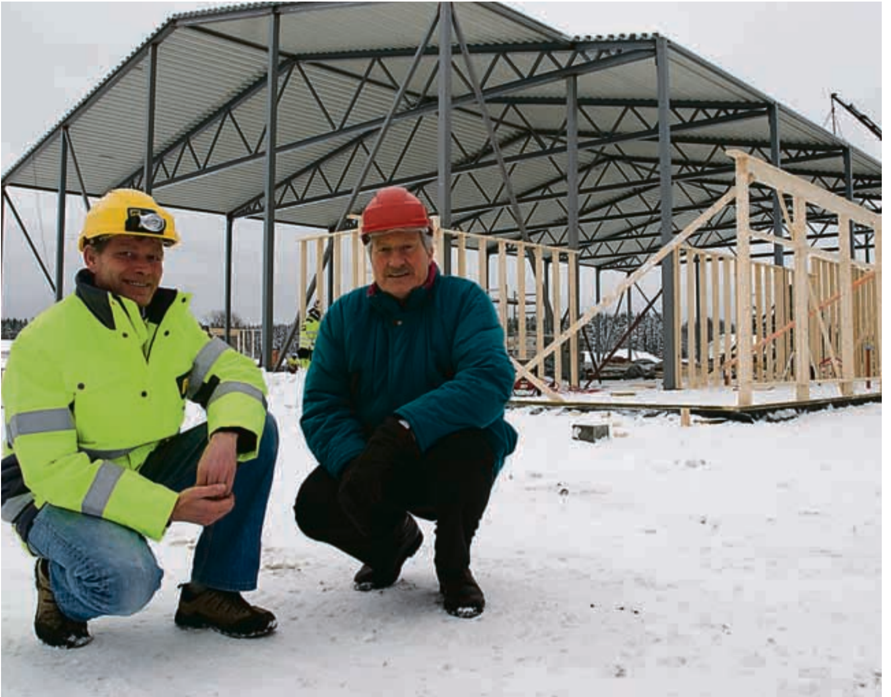
Det skjer mye i Aremark for tiden. Det største er utvilsomt byggingen av idrettshallen like ved Furulund. – Alt er i rute, sier byggeleder i AF Glomsrød Bygg Brynjar Teien og teknisk sjef i kommunen Yngvar Gretland.
