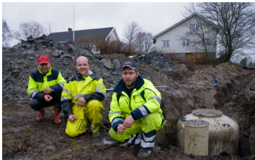
Det nye renseanlegget til Olav Klund (til venstre) ligger fire meter ned i bakken. Rørlegger Stig Erik Granli (i midten) og graver Frode Bernhus gjorde jobben på Klund gård.
