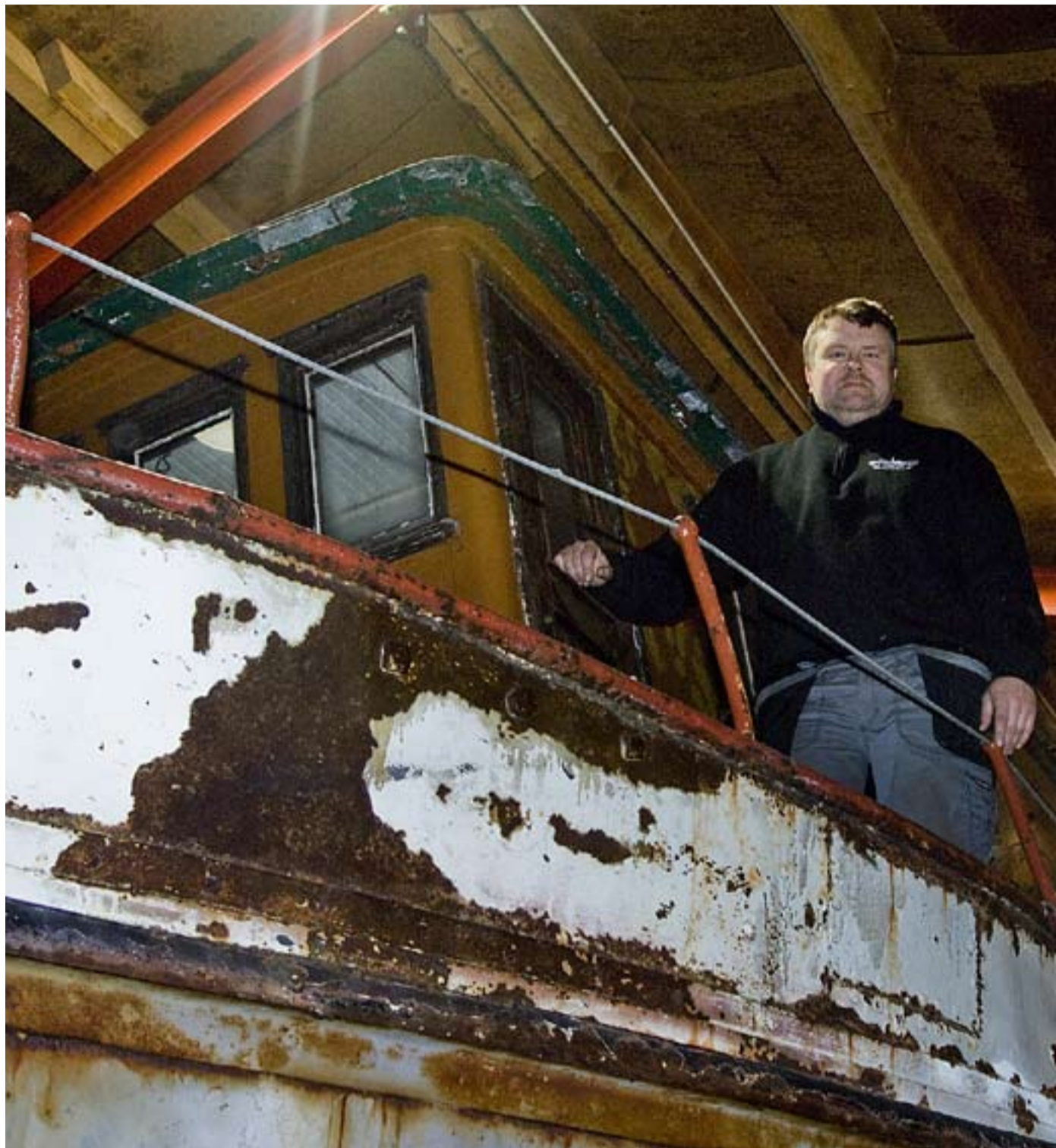
Det er først og fremst skroget som trenger jobb på DS «Pasop». Totalt er restaureringen beregnet til å koste i underkant av fire millioner kroner, forklarer Kjetil Skogdalen.
