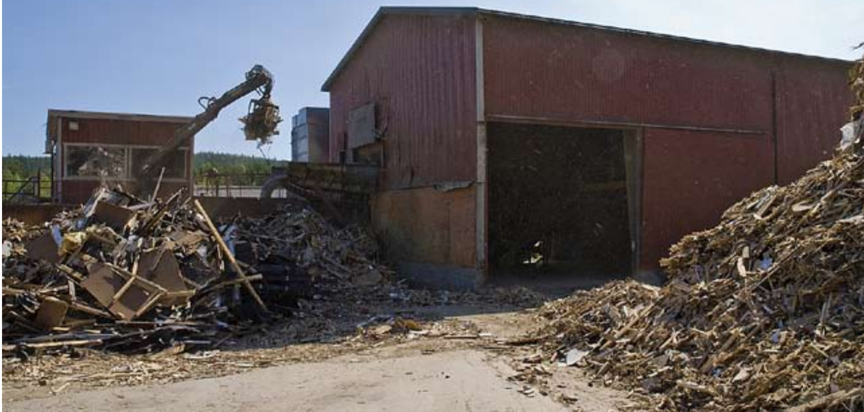
Det støver godt fra arbeidet på biobrenselanlegget. I denne hallen blir materialer sortert ut og trevirke kappet til flis.
