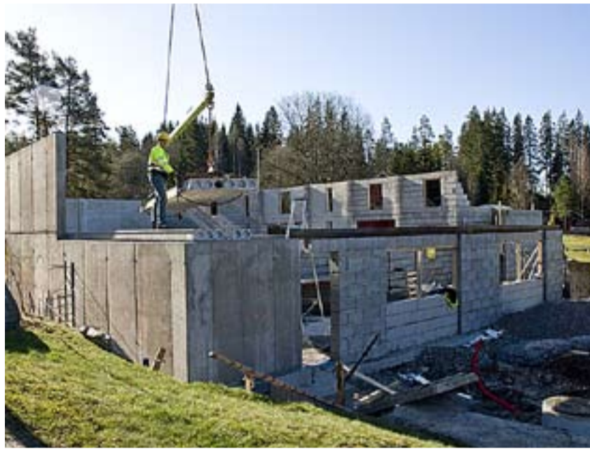
På Fangekasa i Aremark bygges ny møtehall. Hallen skal delvis være klar til å ta imot gjester i sommer. På bildet ser vi byggeleder Martin Glomsrød.
