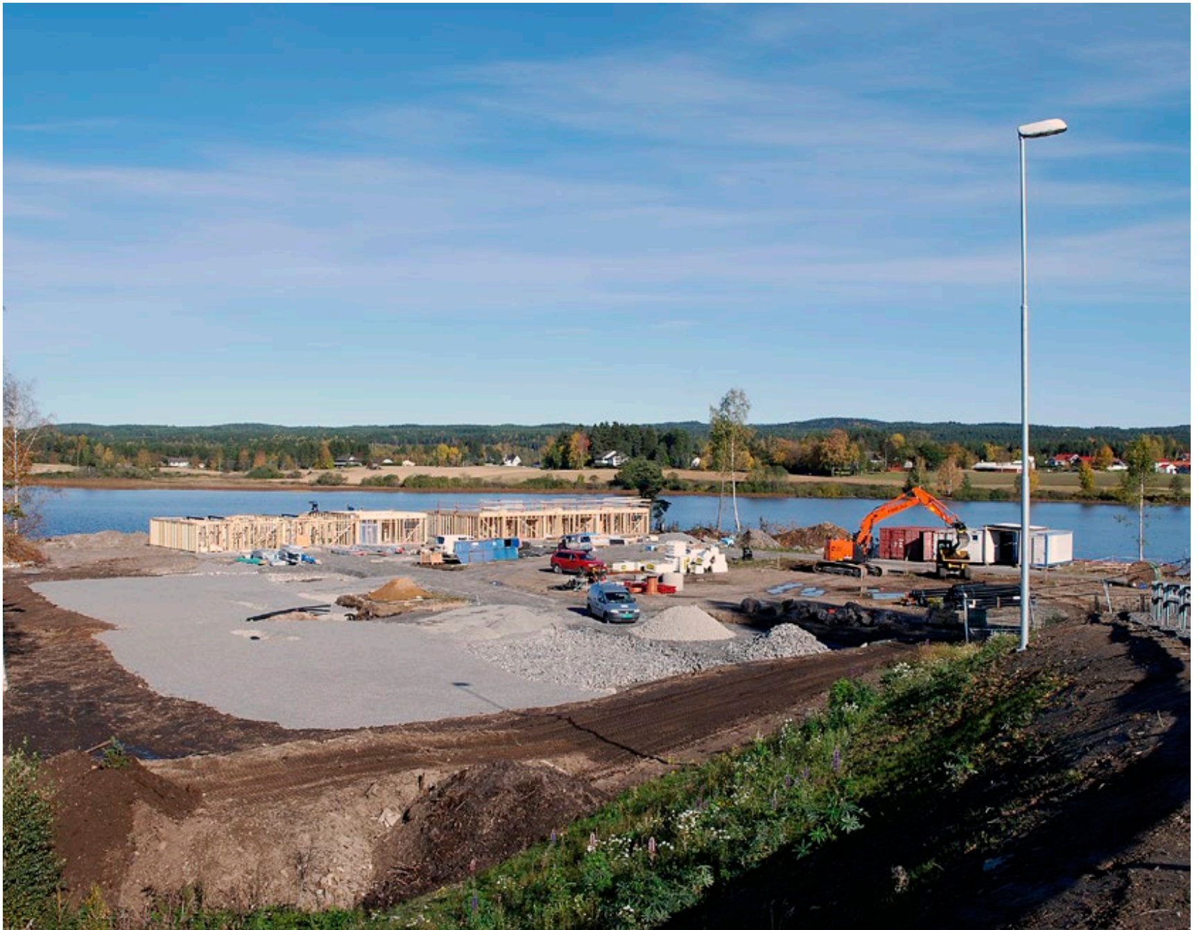
Seks flotte boliger helt i vannkanten på Brårudtangen er under oppføring. Leilighetene er solgt, og til påske kan kjøperne flytte inn i sine nye drømmeboliger. Men fortvil ikke - det er ledige leiligheter i neste byggetrinn.
