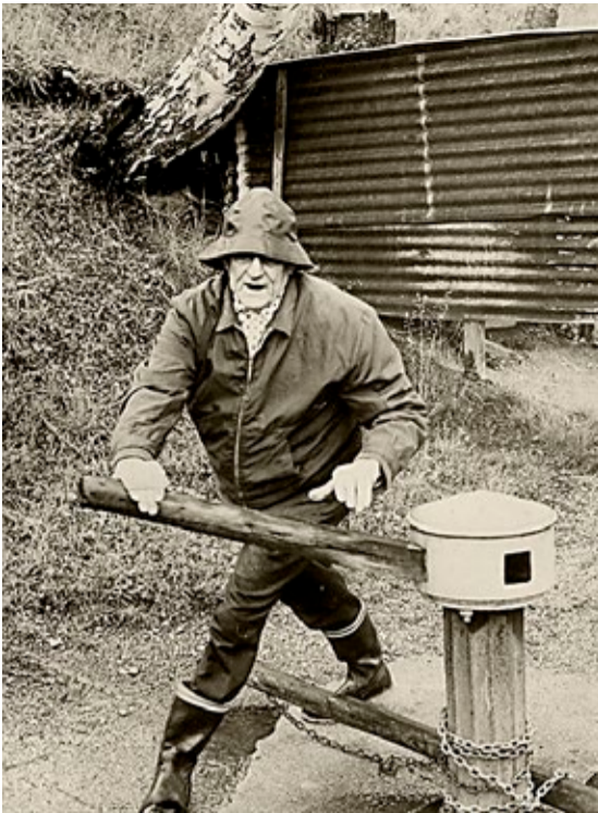
Slusemester Thoralf Jensen i god driv med «Jomfrua» for åpning eller lukking av sluseporten i nedre slusekammer på Ørje.
