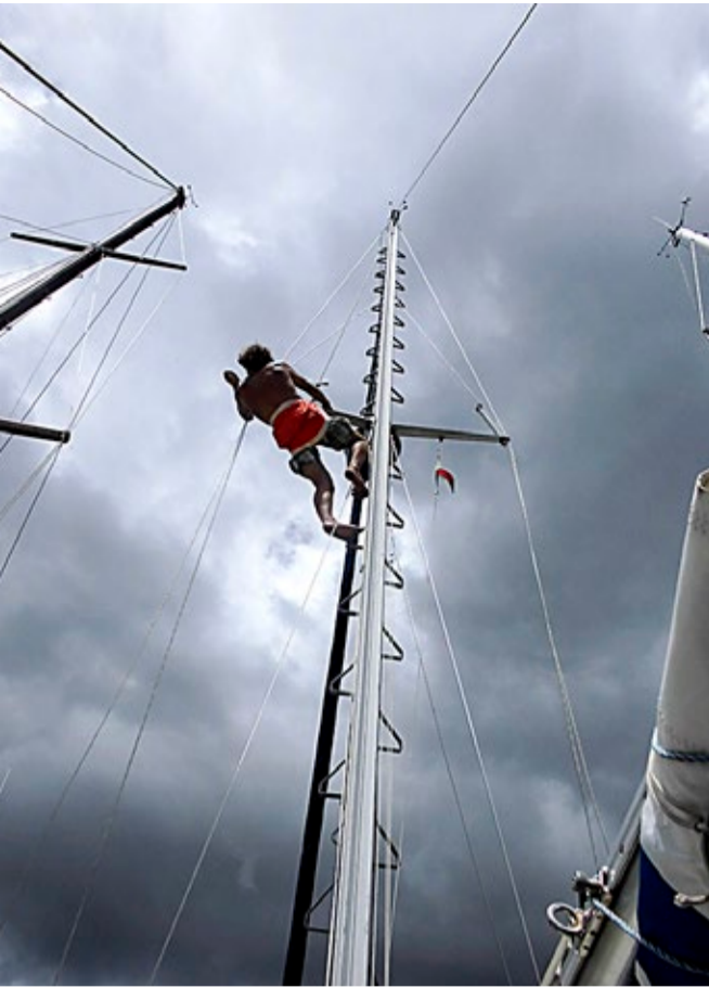
En klatretur opp i det blå måtte til for å sjekke salingens tilstand – aluminiumbjelken som går på tvers av masta.
