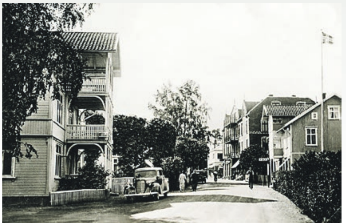
Storgata på Ørje i 1950-årene. Det var schwung over gatebildet den gang. Kastanjetrær, funkisbygg og sveitervillaer hele gata gjennom. I sentrum tronet den mektige Murgården med sine smijernsverander og betongsøyler. Gatelegemet var brosteinbelagt. Riktig en idyllisk landsby. Foto: Astrid Ruud / Marker Fotohistoriske Forum.
