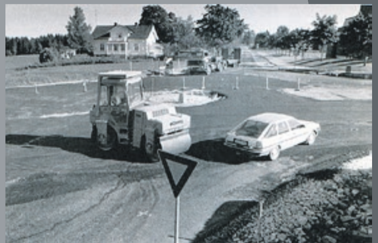
Rundkjøringen ved rådhuset i Ørje ble bygget på 1990-tallet og var den aller første rundkjøringen i Indre Østfold.
